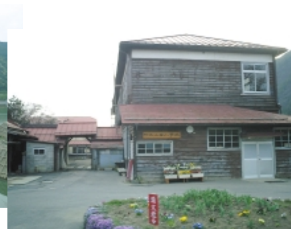
長野県の交流先小学校の外観(築約70年の木造校舎)
