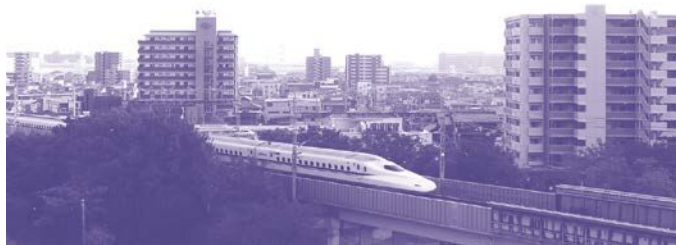
新幹線の防音壁（熱田区二番二丁目）
